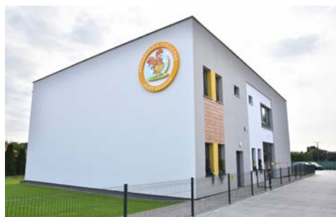
Rozbudowa Przedszkola „Złoty kogucik” str. 11
