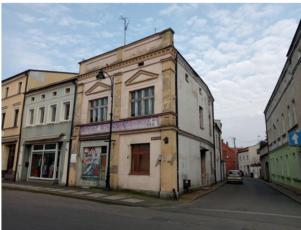
Ryc. 23 Nieużytkowany budynek mieszkalno-usługowy przy ul. Poznańskiej
