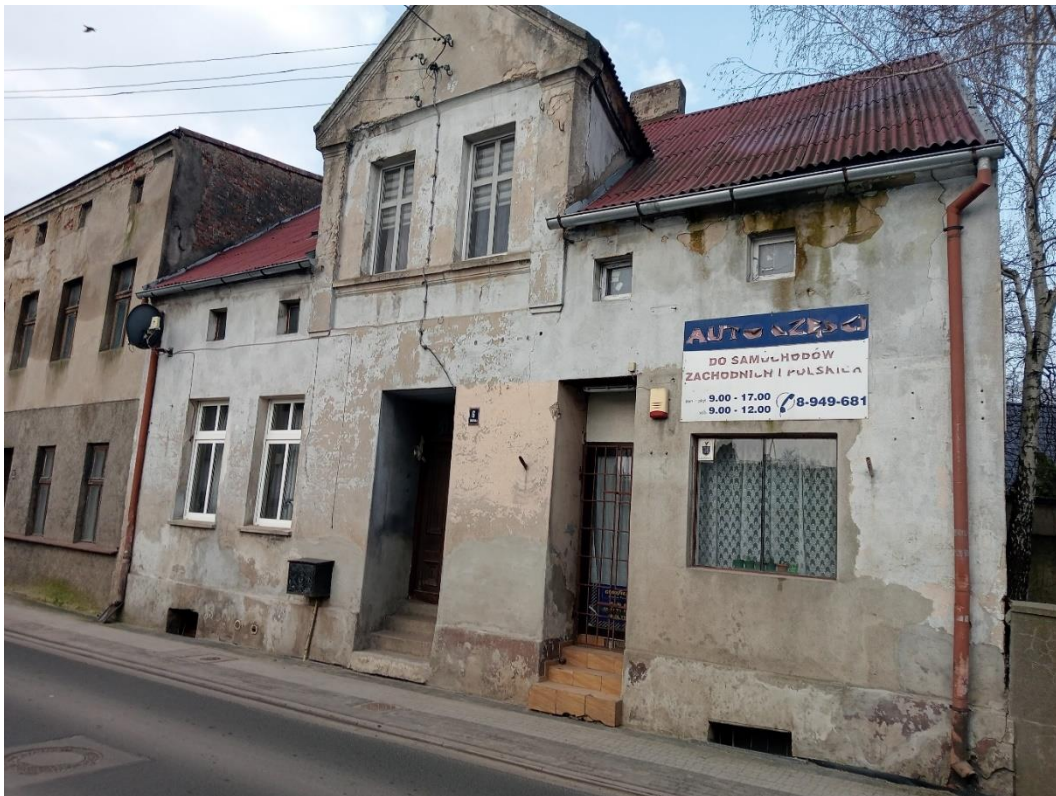
Ryc. 22 Budynek mieszkalno-usługowy przy ul. Grodzkiej
