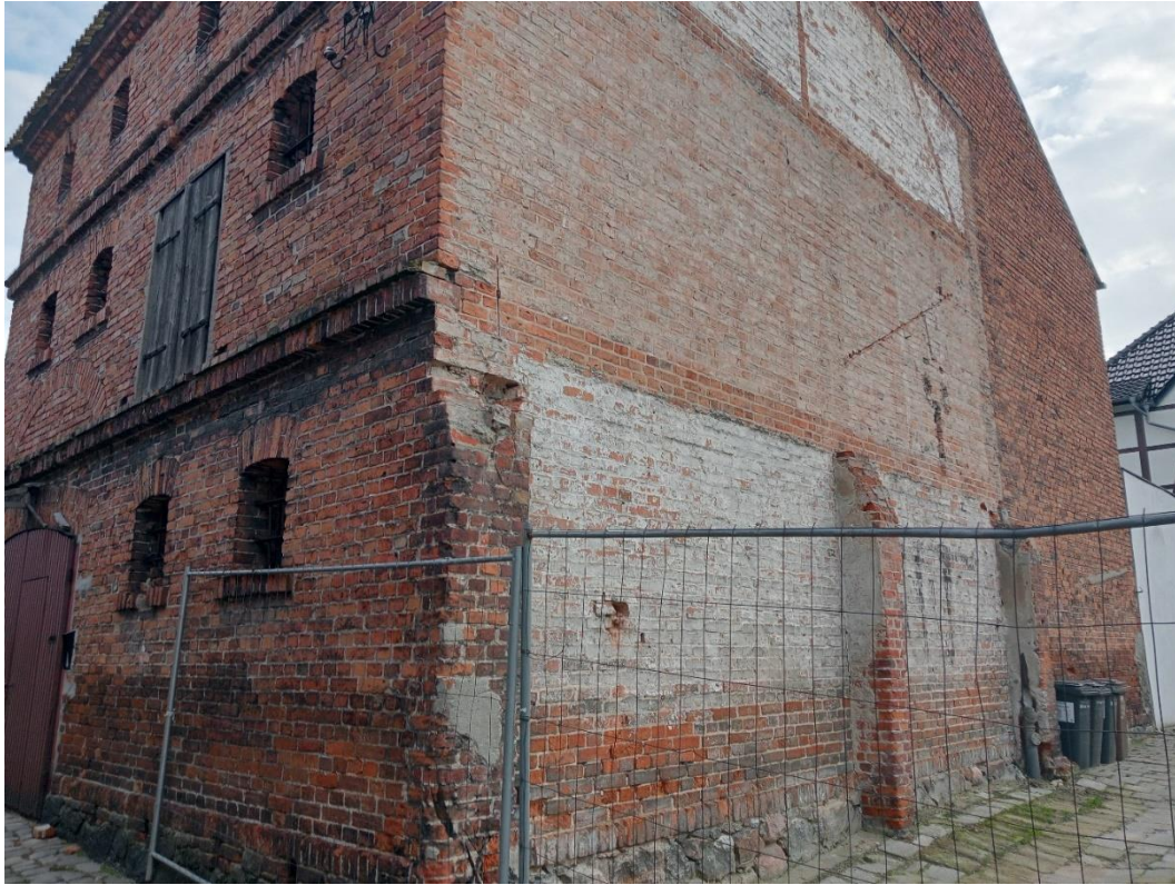
Ryc. 21 Budynek przy ul. Szewskiej
