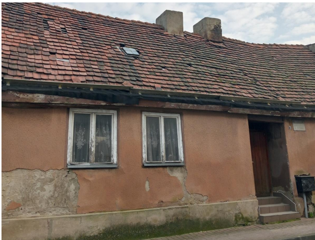
Ryc. 19 Budynek mieszkalny przy ul. Bohaterów Bukowskich
